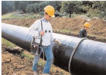
Kontrolle der Isolation der Erdgas-Hochdruckleitung vor dem Einbau.
